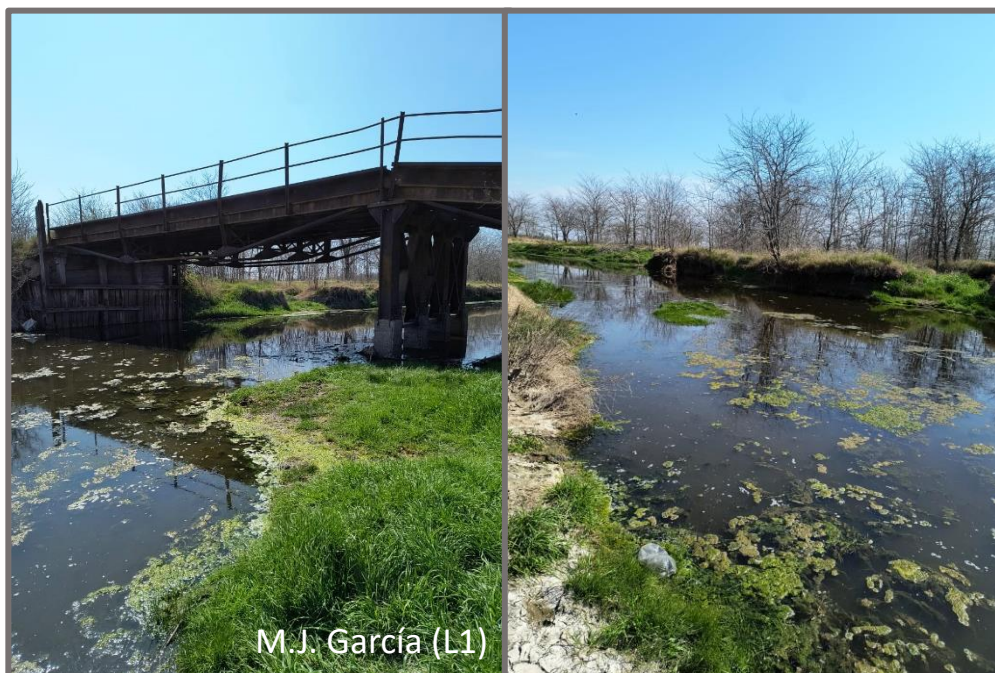
Figura 53. Sitio L1, ubicado en el puente M.J.García.
