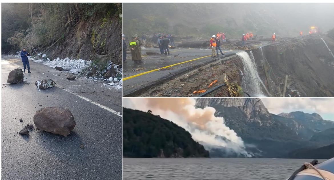
Figura 2.2. Ejemplos de disrupción de accesos viales en la Patagonia andina, requiriendo de acciones de respuesta naval a la emergencia. A la izquierda, caída de rocas sobre la RN 40 en las proximidades de Pto. Arauco (06/06/2020). Arriba a la derecha, flujo de lodo y colapso de la calzada de la RN 231 en las proximidades al Paso Internacional Cardenal Samoré (03/05/2019). Fotos cortesía de Vialidad Nacional Argentina. Abajo a la derecha, operativos de lucha contra los incendios forestales en la región del Brazo Tristeza del Lago Nahuel Huapi (febrero de 2024).
