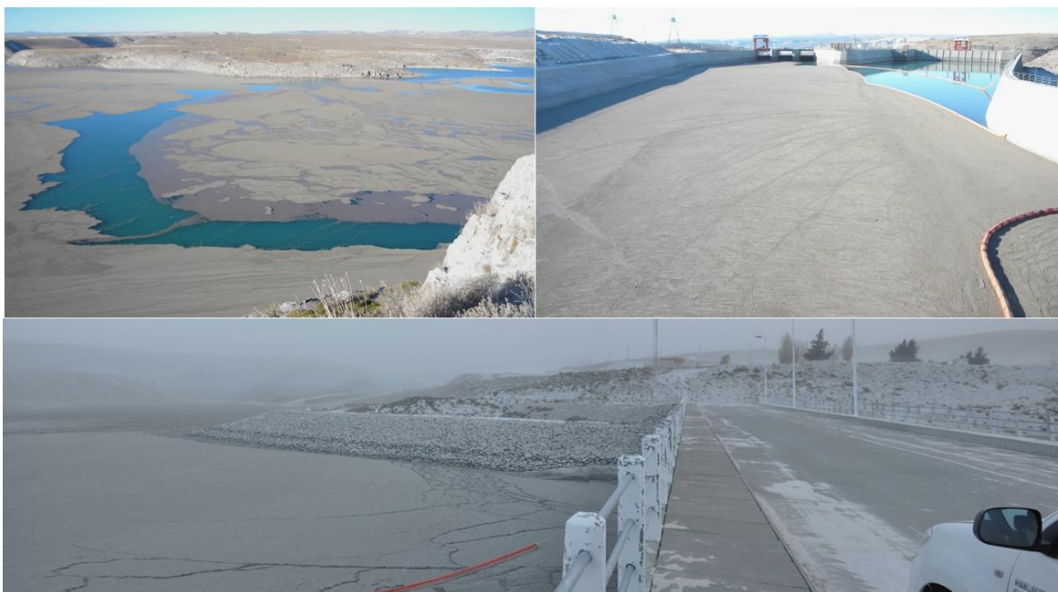
Figura 3.16. Ejemplos de las barreras de contención instaladas para detener y desviar el material pumíceo en flotación arrastrado por el Río Limay hacia la represa hidroeléctrica de Alicurá, durante los primeros días de la erupción (abajo) y las semanas subsiguientes (arriba).
