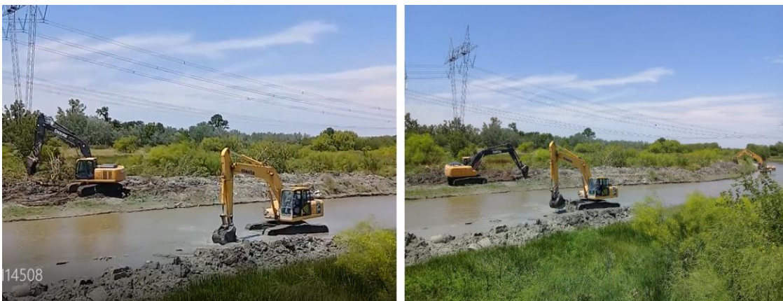
FIGURA 2-8. DRAGAS EFECTUANDO OBRAS SOBRE EL LECHO Y LOS MÁRGENES DEL ARROYO LAS GARZAS
