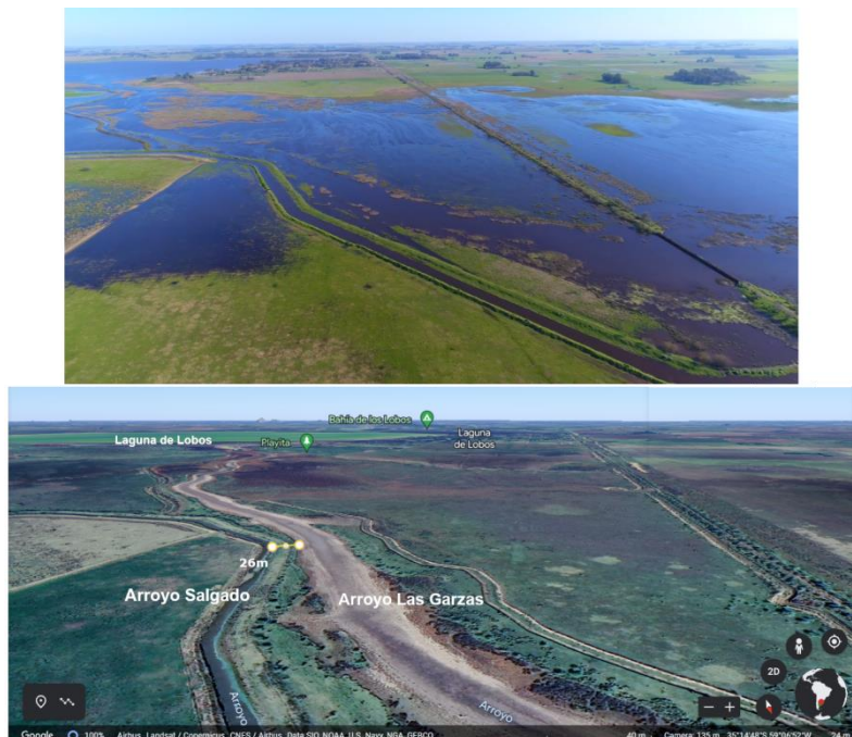
FIGURA 2-12. IMÁGENES DE LA INTERSECCIÓN DE LAS VÍAS CON LOS ARROYOS SALGADO Y LAS GARZAS. EN LA IMAGEN SUPERIOR OBSERVAMOS EL CAUCE DEL ARROYO SALGADO Y LAS GARZAS UNIFICADOS, FUE TOMADA CON UN DRONE EN SEPTIEMBRE DE 2017. LA IMAGEN INFERIOR FUE OBTENIDA DEL GOOGLE EARTH®, SE CORRESPONDE A 10/07/2022.
