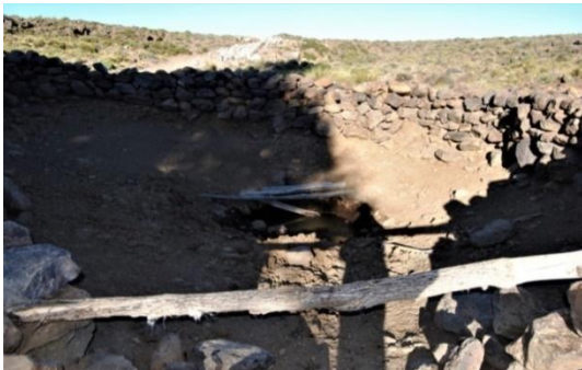
Aguada del puesto de internada casi vacía
