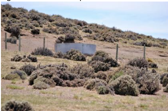
Tanque australiano del sistema de captación de agua
