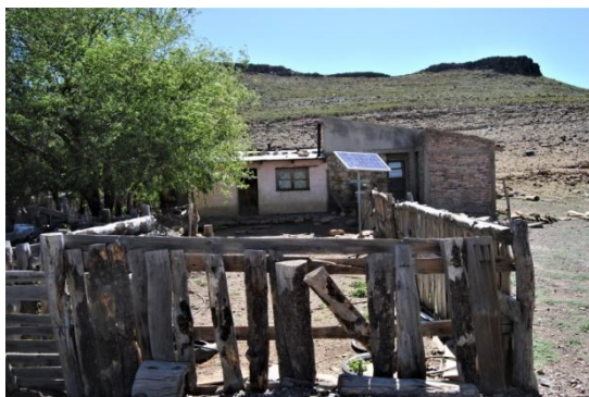
Puesto con su patio interno y panel solar
