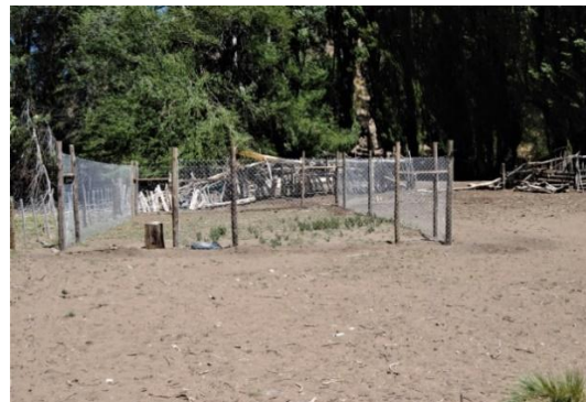
Corral antipuma en construcción
