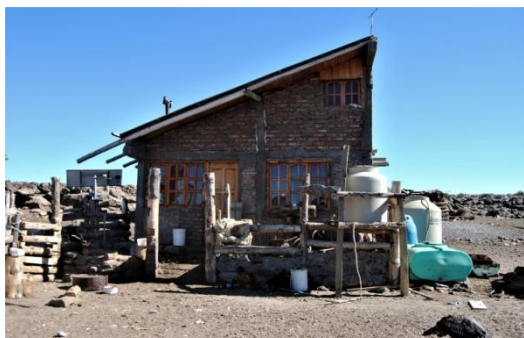
Puesto de invernada con su panel solar y tanque de agua
