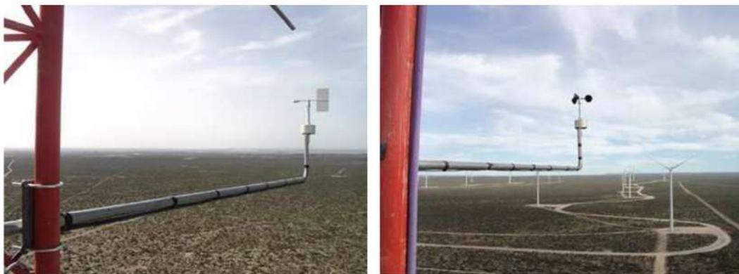
Figura 2.8: Fotografía de la veleta (izquierda) y anemómetro (derecha), ambos VAISALA WAA151, que se encuentran instalados en el mástil meteorológico del PER. Esta fotos fueron provistas gentilmente por la empresa administradora del parque.
