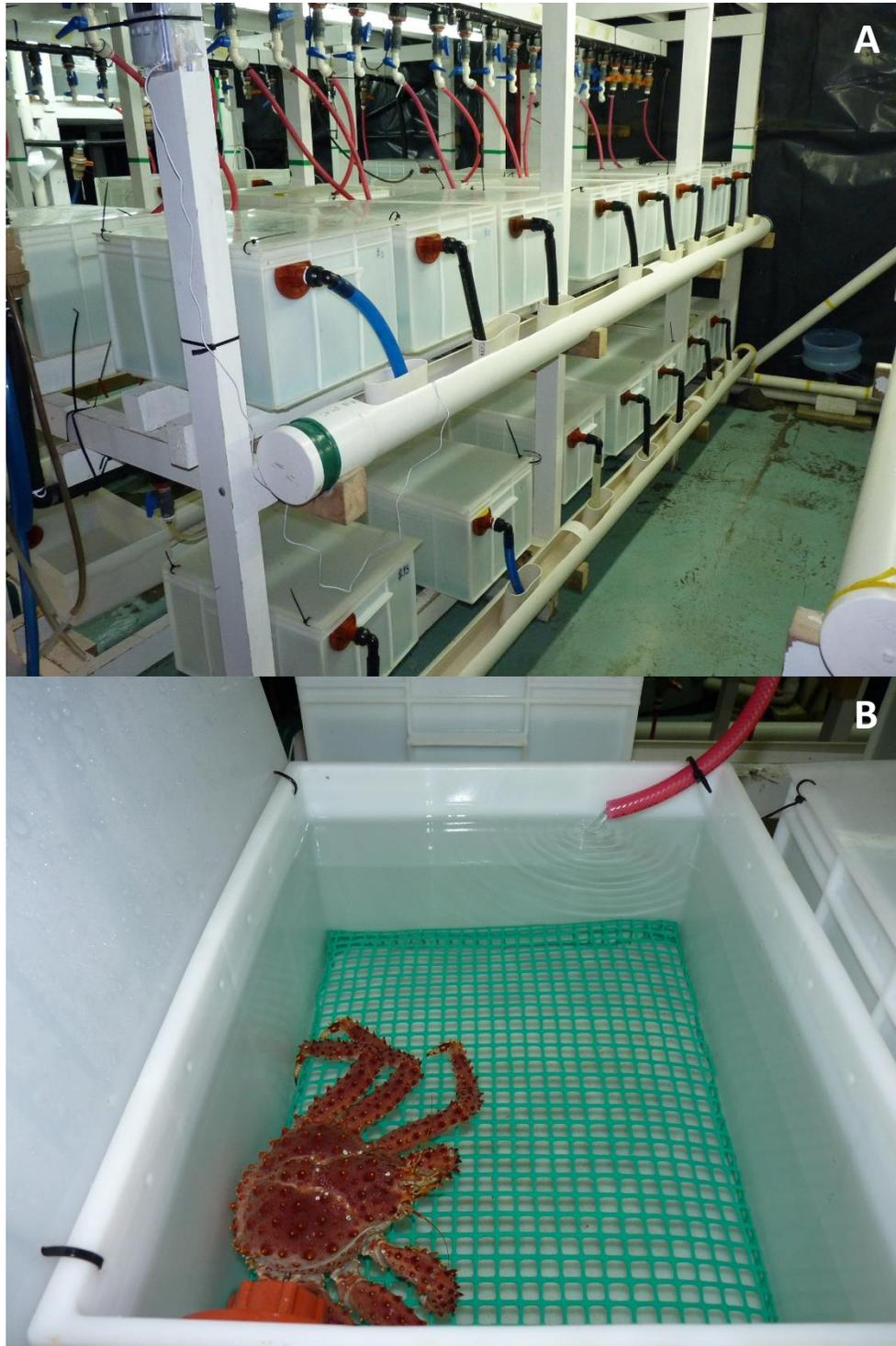
Figura 2.8.8: Instalaciones de acuario del CADIC. A) Sistema de recirculación de agua de mar. B) Detalle de un acuario individual con una hembra ovígera de *L. santolla*. Nótese la malla sobre el fondo que impide que la hembra pueda alimentarse de los huevos perdidos.
