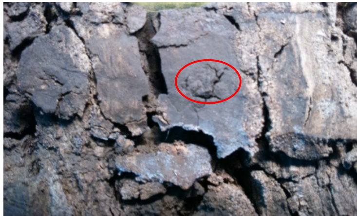
Figura 21: Grieta de contracción en la litofacies Fms
