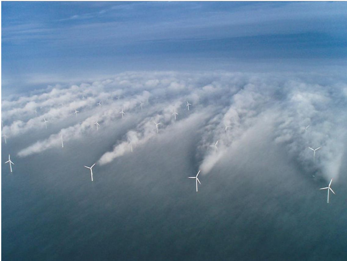
Figura 2.3.1. Turbulencia manifestada a través de la nubosidad para el parque eólico offshore Horns Rev instalado al oeste de Dinamarca. Tomada de [4]. Crédito Vattenfall. Fotógrafo: Christian Steiness.
