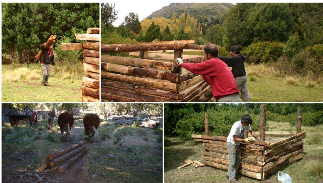
ILUSTRACIÓN 6. Detalle del proceso de construcción de las Unidades experimentales.
