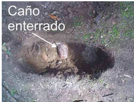
Figura 2.13: Foto de la zona de sondeo luego de excavar para exponer el objeto enterrado.
