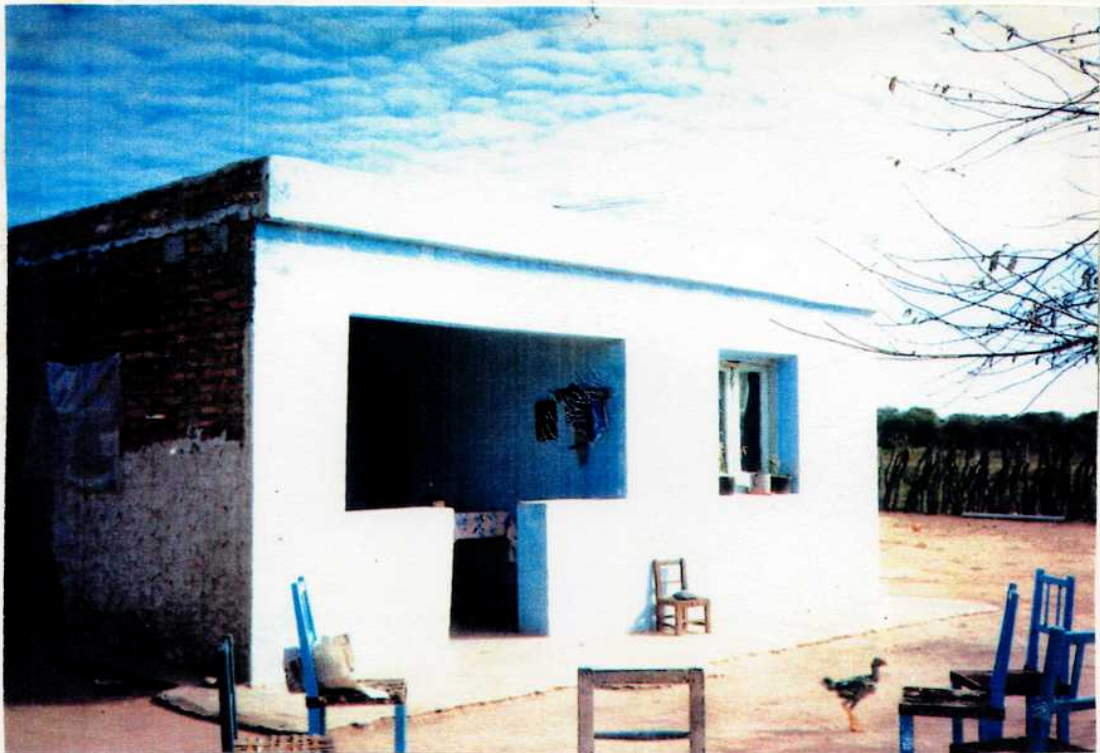
Fig. 6.- Fotografía de una vivienda urbana de paredes revocadas.
