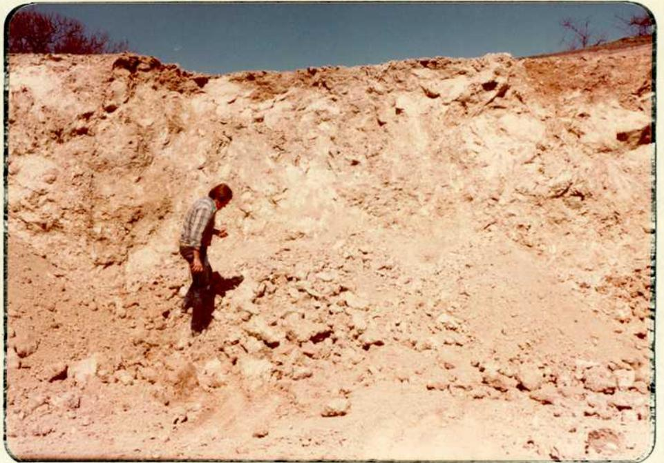
FOTO Nº 17.- Cantera arroyo Las Piedras en el yacimiento Las Piedras-Fray Diego. Frente de cantera explotado mediante palas mecánicas. El espesor del frente de avance es de unos 4 metros.
