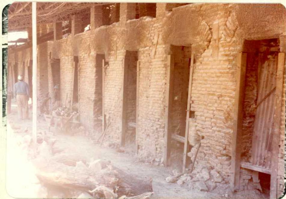
FOTO N° 16.- Baterías de hornos verticales antiguos (fines del siglo pasado) . La deshidratación del mineral de yeso se consigue por cocción a fuego directo mediante 35 horas (utilizando leña como combustible). La temperatura de cocción oscila entre 100 y 120 °C.
