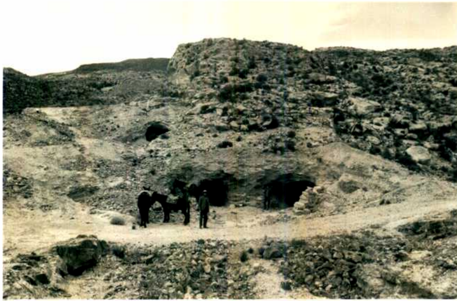
fig.18. La fotografía ilustra un detalle de algunas de las labores de explotación de tipo pirquén del denominado grupo Las Filipinas. Eran productoras de baritina y galena; se localizan en el contacto de las brechas calcáreas de la Formación San Juan infrayacente y las areniscas blancas del miembro superior de la Formación Volcán.
