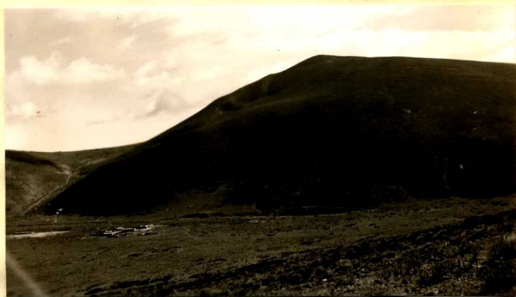
Falda sudoeste del Cerro Mallín Quemado. Obsérvense el campamento-administración y la entrada del socavón playa 6.-
