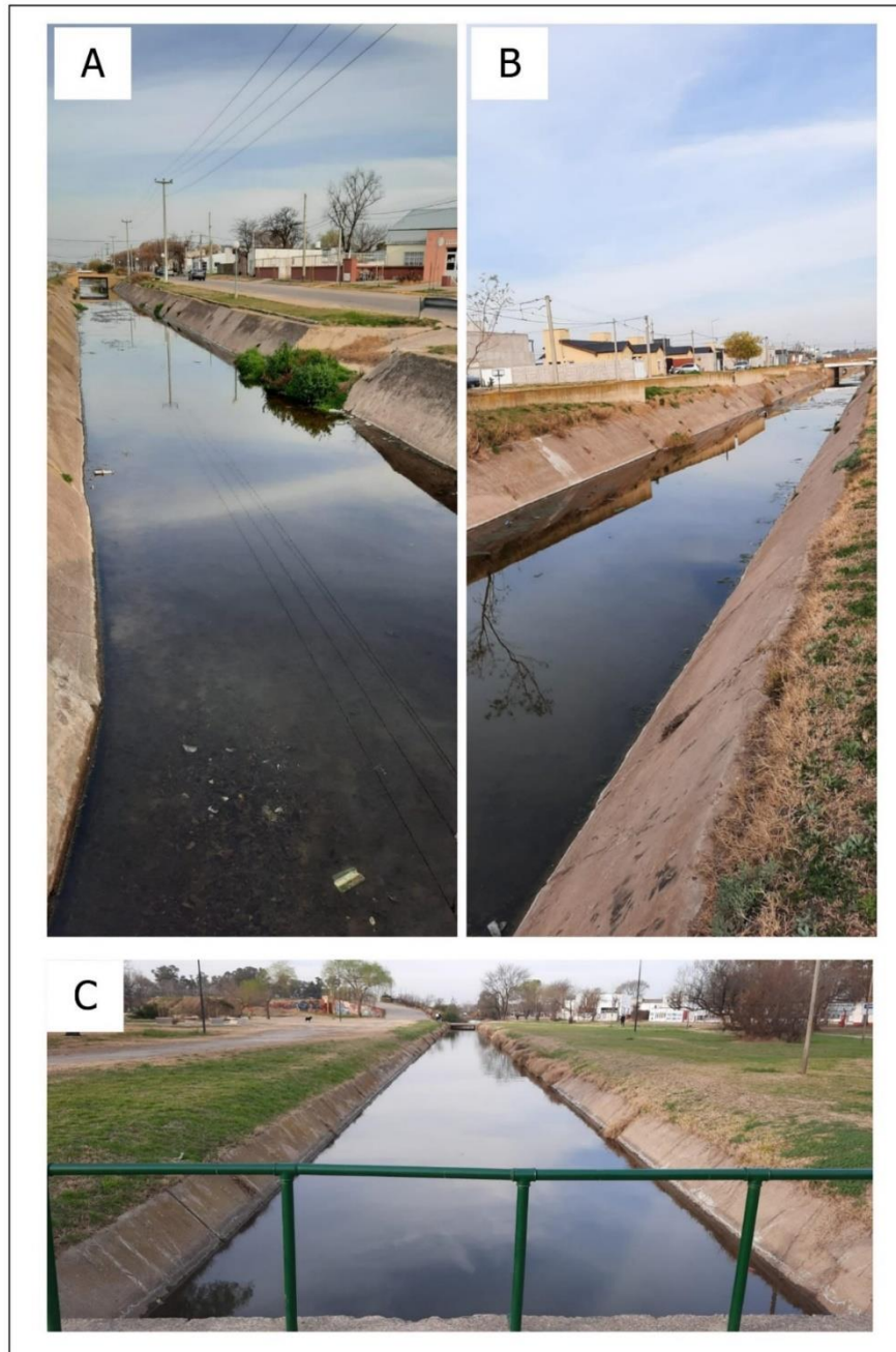
Figura 38. Canales a cielo abierto trapezoidales revestidos con hormigón. A. Se puede observar vegetación obstruyendo parcialmente la entrada de agua de un canal tributario. B. Muros verticales por sobre el nivel del revestimiento del canal. C. Canal en buen estado de mantenimiento.
