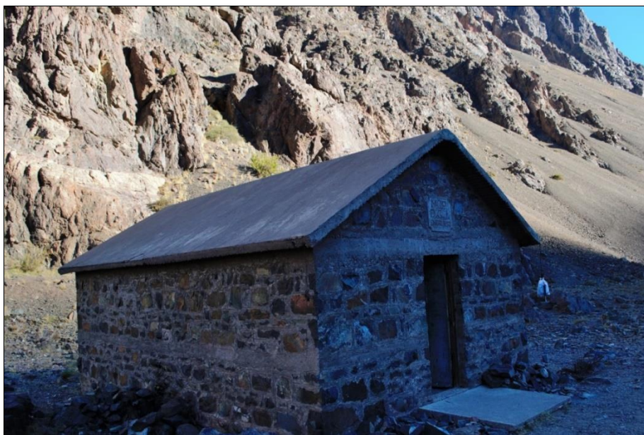
Figura 2: Vista hacia el oeste del refugio ubicado en la confluencia entre los ríos Blanco y Tupungato.
