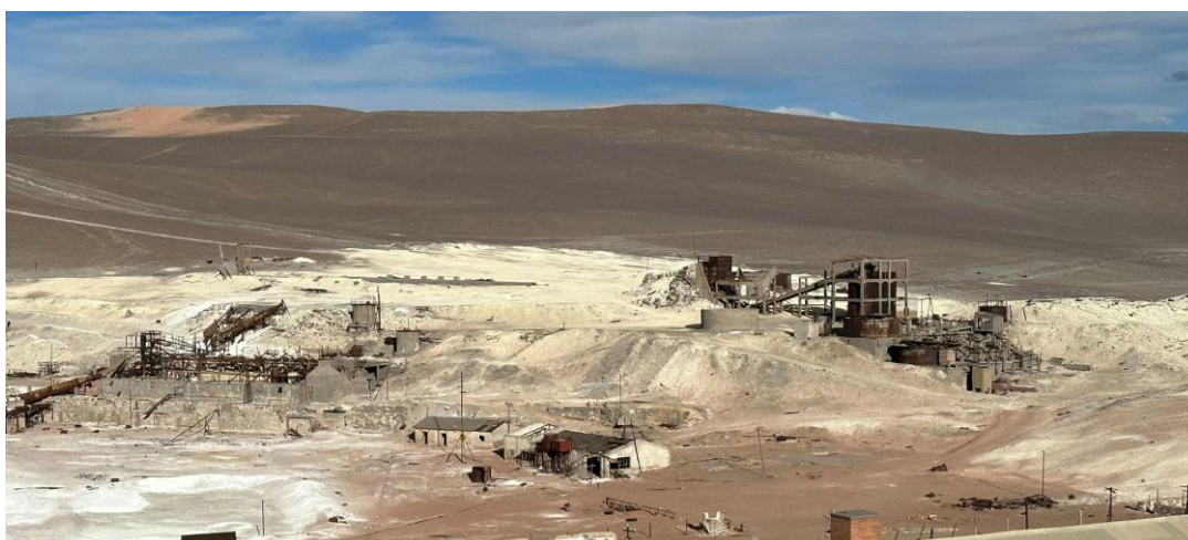
Figura 37. Planta de tratamiento denominada La Casualidad a una altura de 4.200 m.s.n.m.
