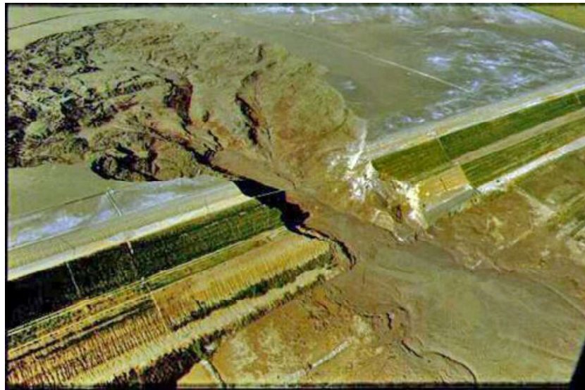
Figura 6.4. Imagen aérea tomada luego de la destrucción de la presa de Merriespruit. Fuente: Mineral Council South Africa (2020), https://www.mineralscouncil.org.za/industry-news/we-care-we-remember/324-we-remember-merriespruit .
