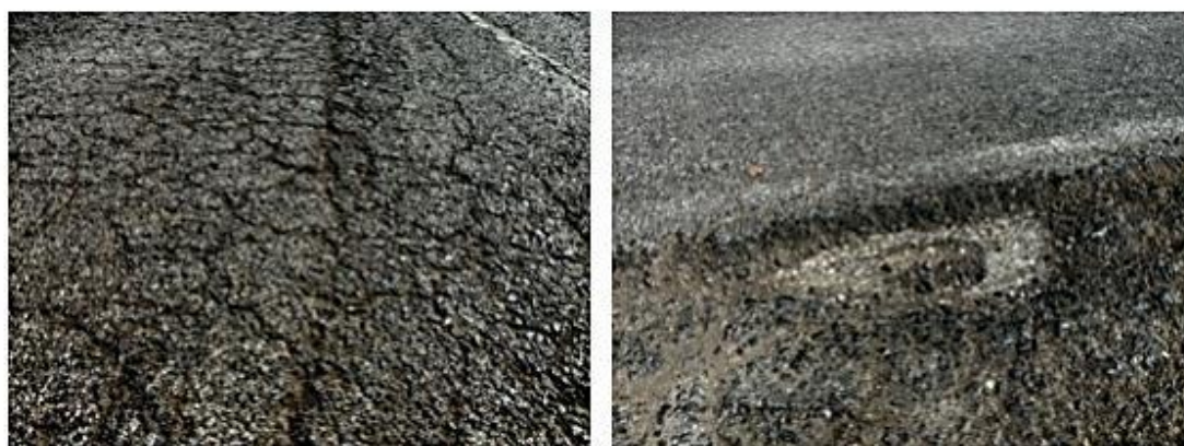
Figura 50. Daños sobre el pavimento provocados por diversas causas incluyendo el uso de sales de deshielo. Tomado de Gándara (2020).
