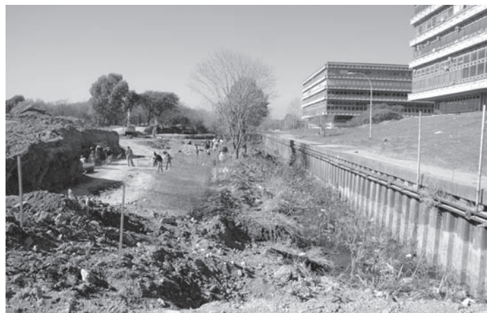
Trabajos frente a los pabellones II y III
