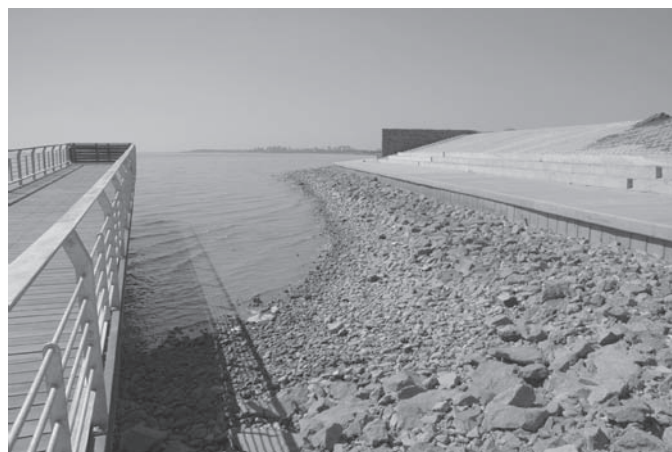
Vista actual de la obra frente a la costa
